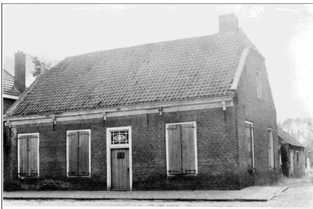
Tijdens de bouw van het klooster op de Donk, verbleven de zusters in de woning Rommens, gelegen aan de zuidkant van de Dorpsstraat tegenover het toenmalig postgebouw
