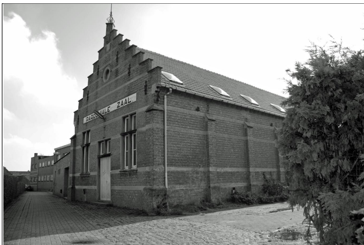
De parochiezaal langs de Mussenakker nadat het dak vernieuwd is.
