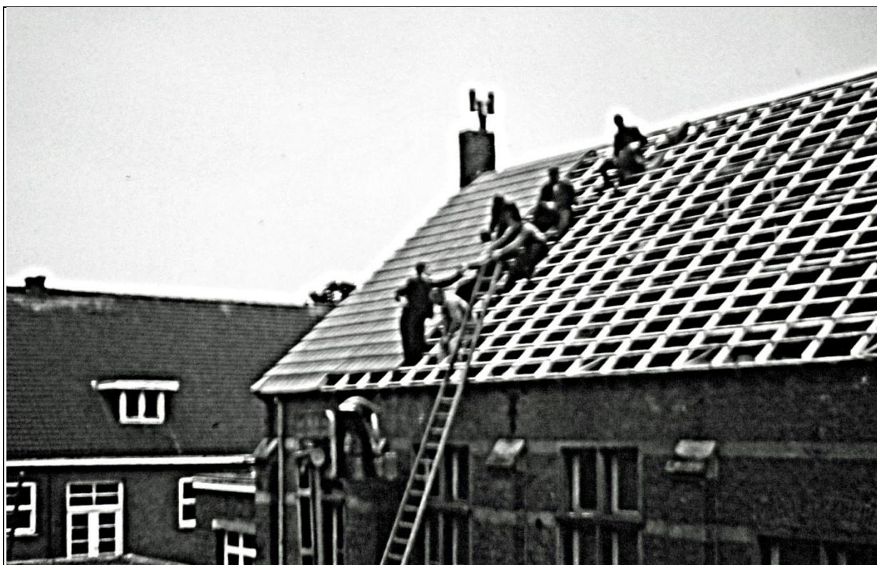
De vernieuwde dakconstructie (1971 – 1973) van de parochiezaal met op de achtergrond de kleuterschool gebouwd in 1956
